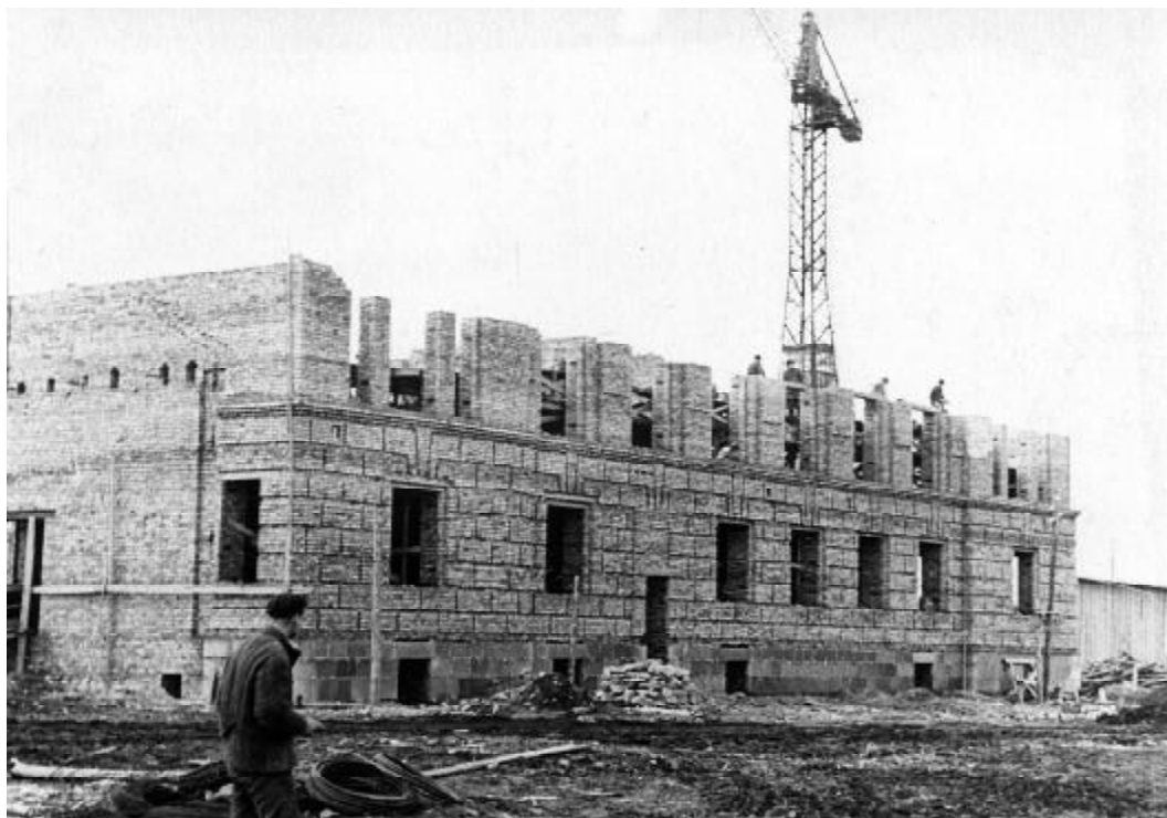
1955 г. Начало строительства...
